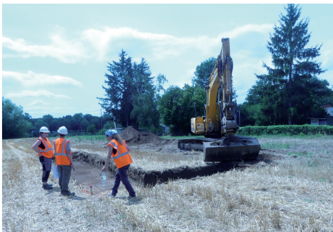
Fig. 10 Décapage en cours du secteur 2 (Photo : E. Dubreucq)
