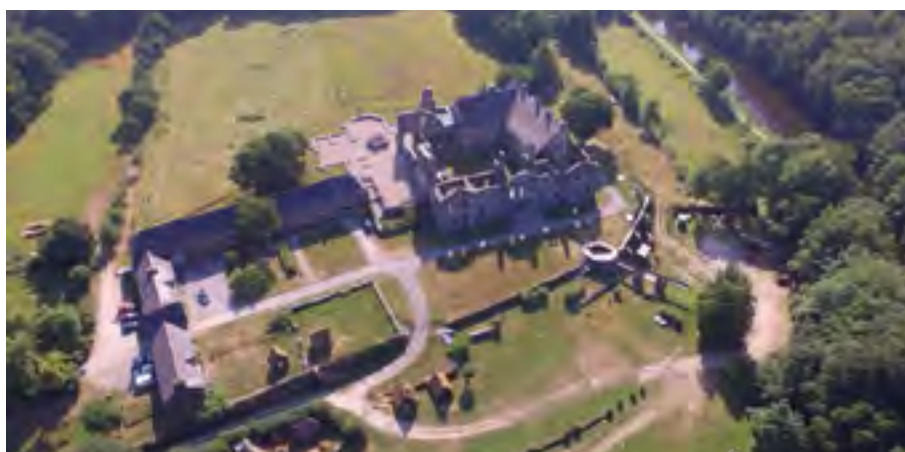
Figure 155 : Bon-Repos-sur-Blavet (22), Abbaye du Bon-Repos – vue aérienne depuis l'ouest de l'abbaye de Bon-Repos (cl. R. Peron).
