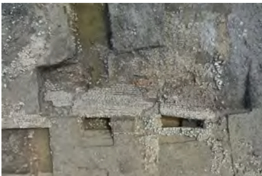
Figure 121 : Boigny-sur-Bionne (45) ZAC de la Clairière – mur effondré (cl. Archeodunum SAS).
