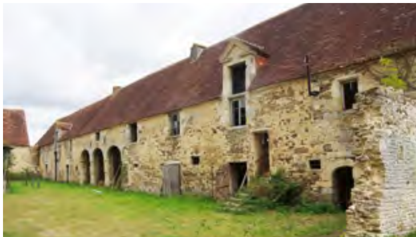
Figure 152 : Avoine (61), Château – vue du corps de ferme.
