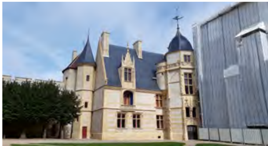
Figure 153 : Ainay-le-vieil (10), Château – vue partielle du logis du XV e siècle (cl. C. Collomb).
