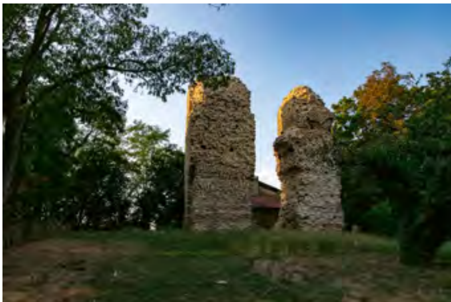
Figure 112 : Craponne (69), Les Tourillons, voie romaine – Vue des piles de l'aqueduc de l'Yzeron (cl. D. Baldassari).
