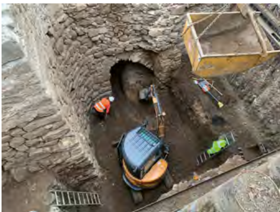
Figure 137 : Montbrison (42) – Les remparts, vue de la fouille à l'intérieur des fortifications.
