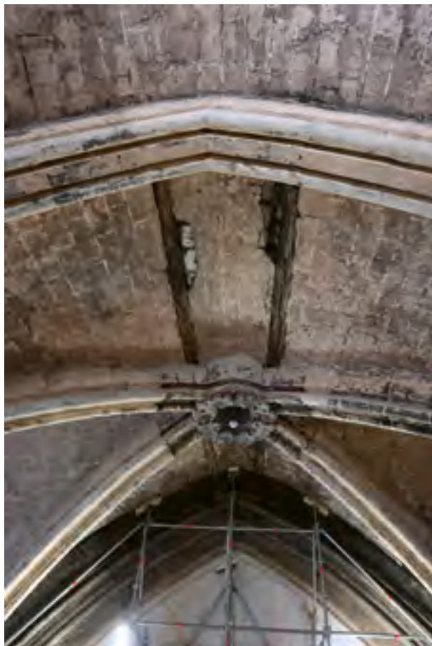
Figure 253 : Chartres (28), Cathédrale – tirant pris dans la voûte du bras sud du transept.
