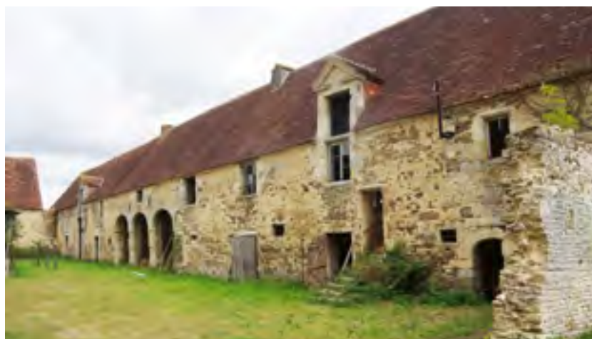
Figure 152 : Avoine (61), Château – vue du corps de ferme.
