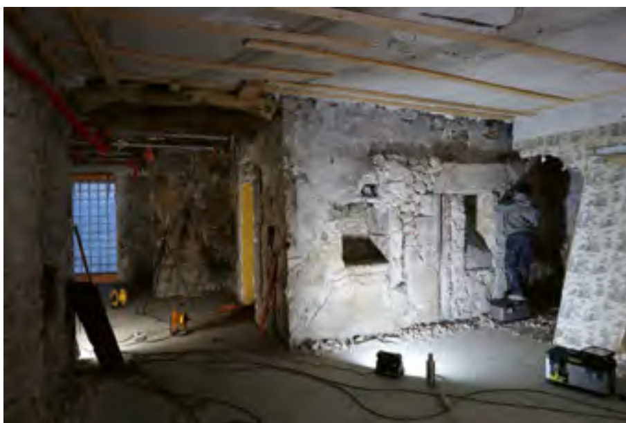
Figure 162 : Mende (48), 7-9 rue de la Liberté – vue du chantier et des maçonneries en second œuvre. Les éléments visibles sur cette photographie montrent bien le temps long de l'occupation du bâtiment (cl. C. Rivals).
