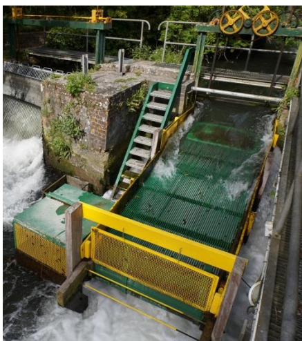
Figure 8: Vue du dispositif de piégeage de dévalaison d'Eu
