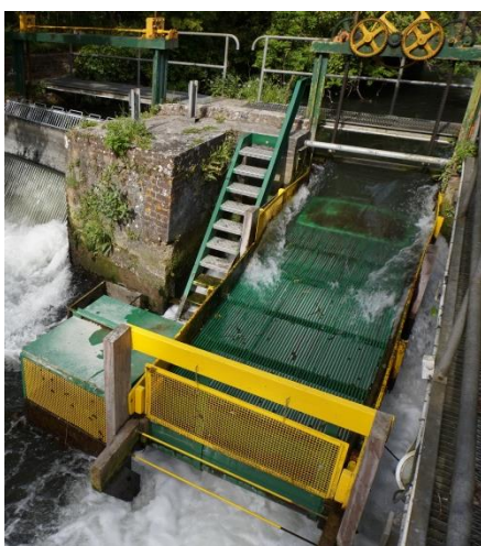
Figure 8: Vue du dispositif de piégeage de dévalaison d'Eu
