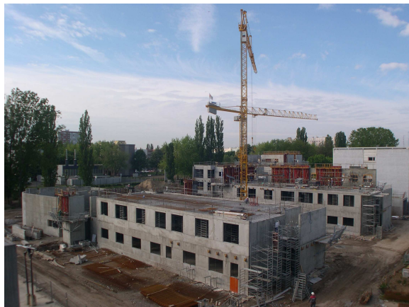
L'ampleur du chantier du bâtiment
