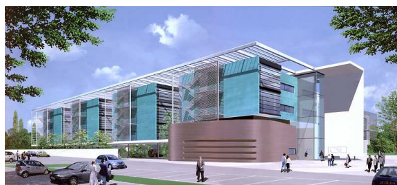
Le bâtiment terminé(extérieur)
