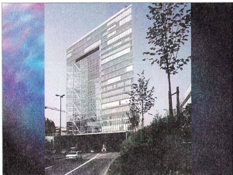
Accès sud sous l'immeuble-tour en verre construit (après l'ouverture du tunnel) au-dessus de l'accès sud, non-prévu au départ, dont les fondations ont pu être intégrées dans la construction du tunnel
