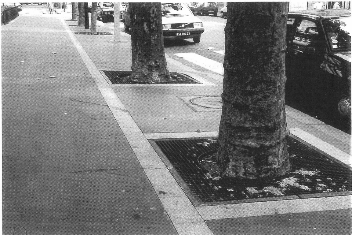
Revêtements bitumineux et grilles d'arbres à maille carrée à proximité du square de la Roquette.
