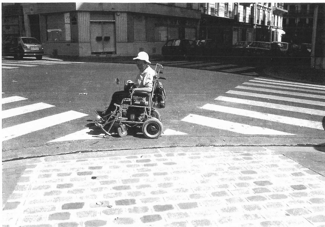
Accès au square Maurice Gardette : un revêtement et un abaissement adapté.
