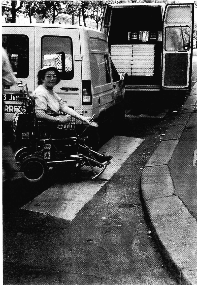
Angle rue de la Roquette, rue Richard Lenoir : un trottoir inaccessible pour des handicapés.
