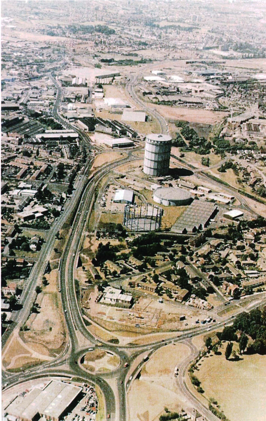
Fig. 6 : Vue aérienne de la "Spine Road" à Swan Village (après réalisation) (source: New Civil Engineer)
