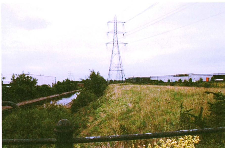
Fig. 13 : Les pylônes électriques ont été conservés là où leur déplacement ou l'enfouissement des lignes étaient trop coûteux (source: Noha Nasser)
