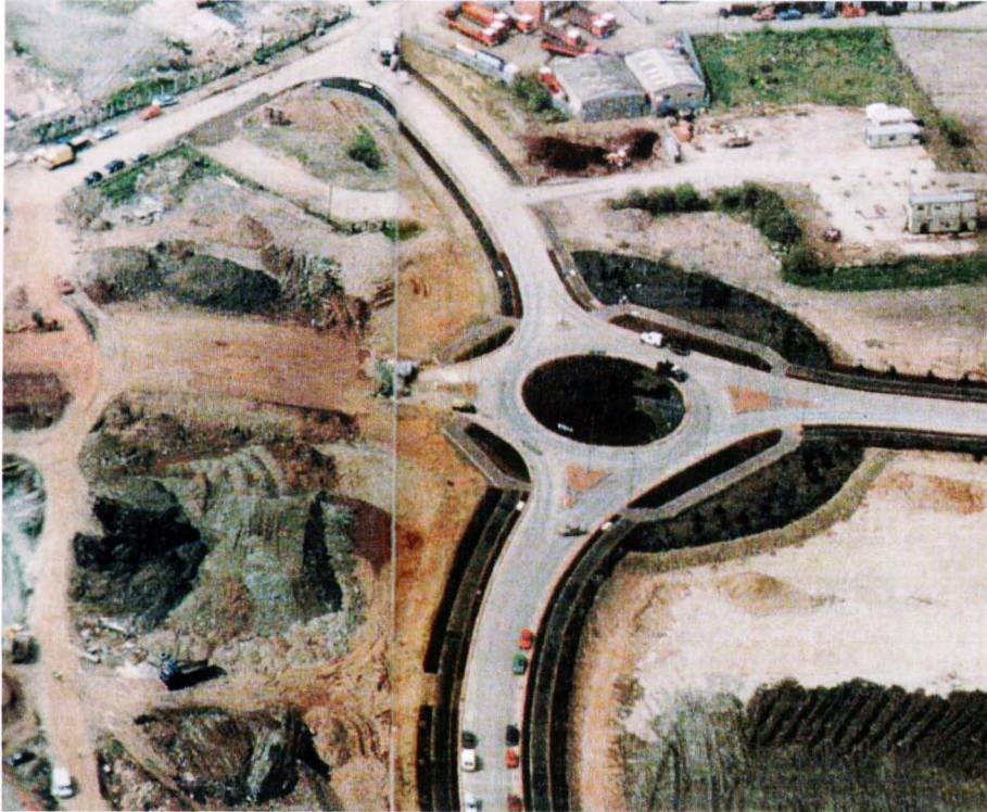
Fig. 20 : Un rond point de la "Spine Road"(Contrat 4) (source : New Civil Engineer)
