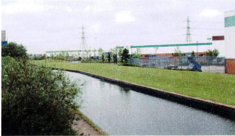
Fig. 8 : La réhabilitation des canaux et la mise en valeur de l'environnement urbain constituent des éléments importants dans la stratégie de valorisation de la zone développée par la BCDC (source: Noha Nasser)
