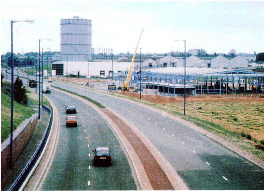
Fig. 14b : la route réalisée (source: New Civil Engineer)
