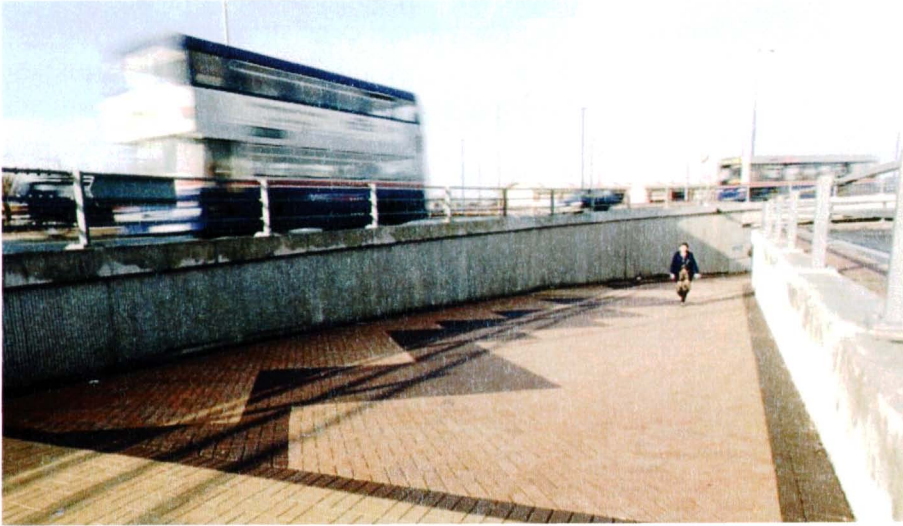
Fig 21: Les passages piétonniers souterrains ont été considérés comme les aménagements les plus sûrs pour traverser la « Spine Road »
