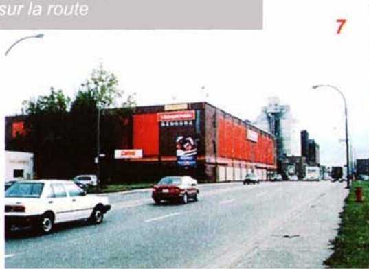
FIGURE 7 : L'Entrepot Public, rue Notre Dame Est, trottoirs en mauvais état et donnant directement sur la route
