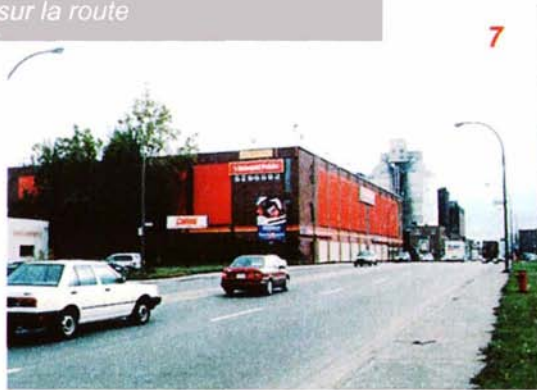
FIGURE 7 : L'Entrepot Public, rue Notre Dame Est, trottoirs en mauvais état et donnant directement sur la route
