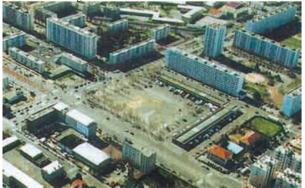
Place avant aménagement
