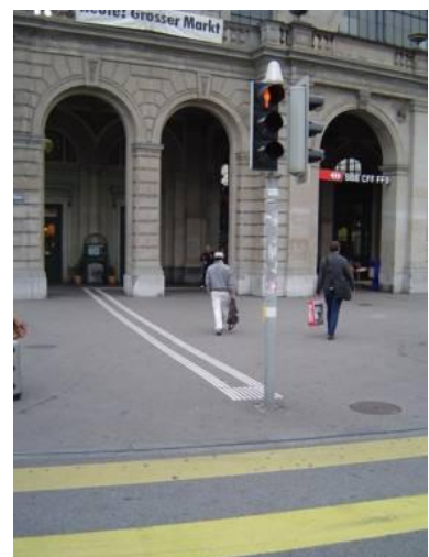
Accès au répéteur feu piéton, Suisse
