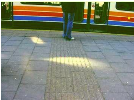
UK, accès au quai du tramway
