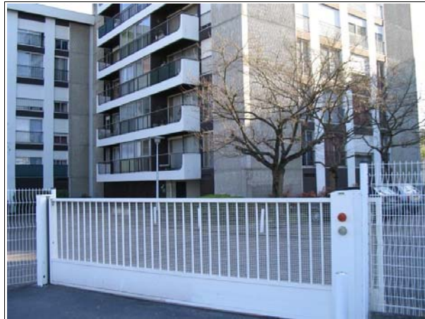
Un portail coulissant permet l'accès aux véhicules : le stationnement est intégré dans l'espace fermé Photographie : CETE SO
