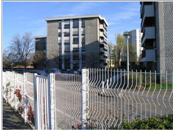
Clôture « étanche » entourant le site Photographie : CETE SO
