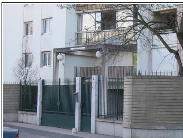
Les dispositifs de contrôle d'accès sont aujourd'hui considérés comme très agressifs. Photographie : CETE SO
