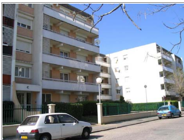
Les entrées sont laissées ouvertes Photographie : CETE SO
