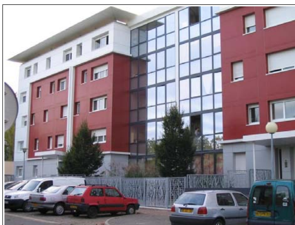
La réfection des façades en rouge et blanc ainsi que les baies vitrées ont fortement contribué à l'amélioration de l'esthétique de la résidence Photographie : CETE SO
