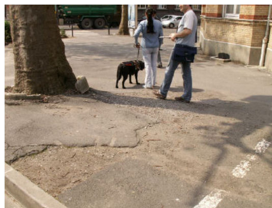
Illustration 19: Exemples de problèmes liés au revêtement du trottoir
