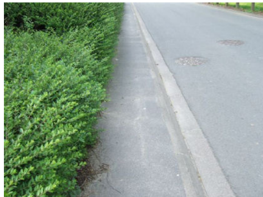
Illustration 23: Exemple de problèmes liés aux caractéristiques géométriques des trottoirs
