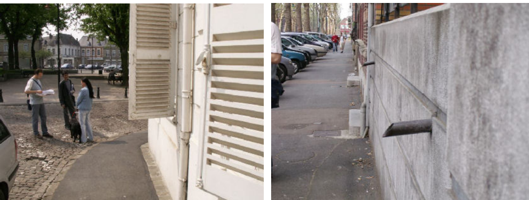
Illustration 21: Exemples d'obstacles en porte à faux
