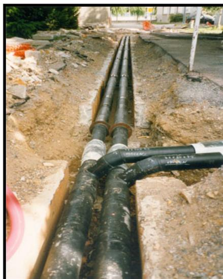
*Photo 11 : Canalisation de chauffage urbain technique Wanner
