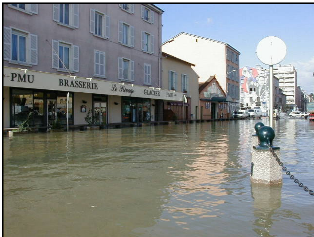
Photo 10 : Submersion du quai des Marans, cote 6,54 m (Service Technique de la Ville de Mâcon)
