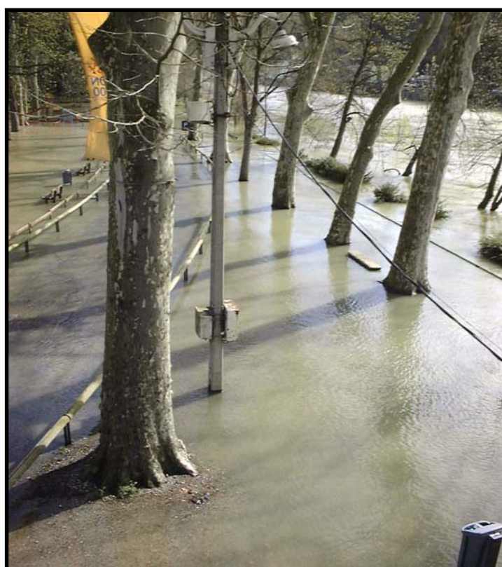
Photo 16 : Armoire positionnée en hauteur sur l'île Barbe (source Division Éclairage Public Lyon)
