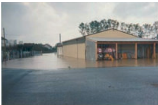
Photo n°5 : Centre d'exploitation de la subdivision de l'Équipement de Roussillon inondé (Source : Subdivision de Roussillon-Beaurepaire)
