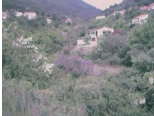
Photo n°12 : Construction avec remblai dans le lit mineur d'un ruisseau à sec au sud de Saint-Ambroix
