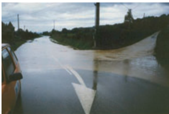
Photo n°2 : Fortes venues d'eau de la RD51 (Source : Subdivision de Roussillon-Beaurepaire)
