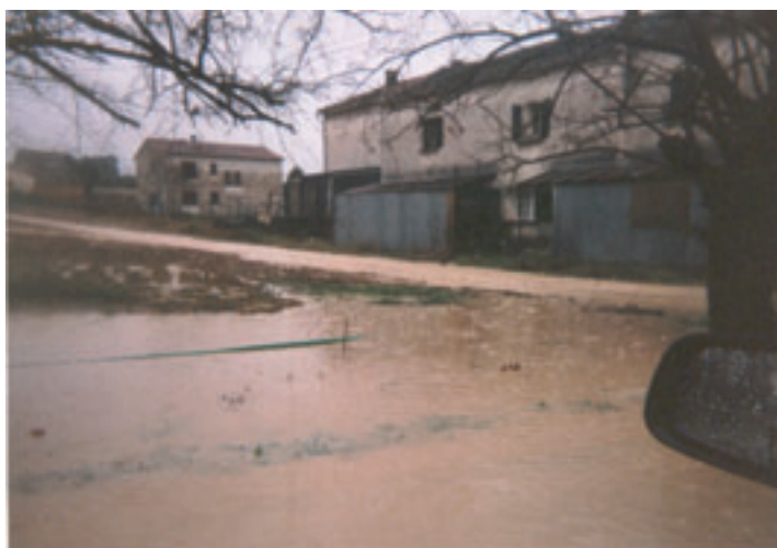
Photo n°14 : Maisons menacées d'inondation par ruissellement urbain à Méjannes-lès-Alès (Photo : F. Dégardin)
