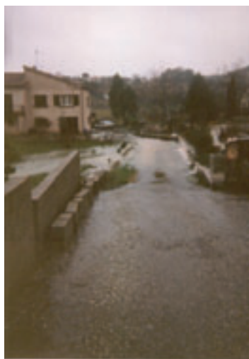
Photo n°11 : Pont inondé à Méjannes-lès-Alès (Photo : F. Dégardin)
