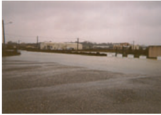
Photo n°9 : Écoulement en nappe sur la chaussée (F. Dégardin)
