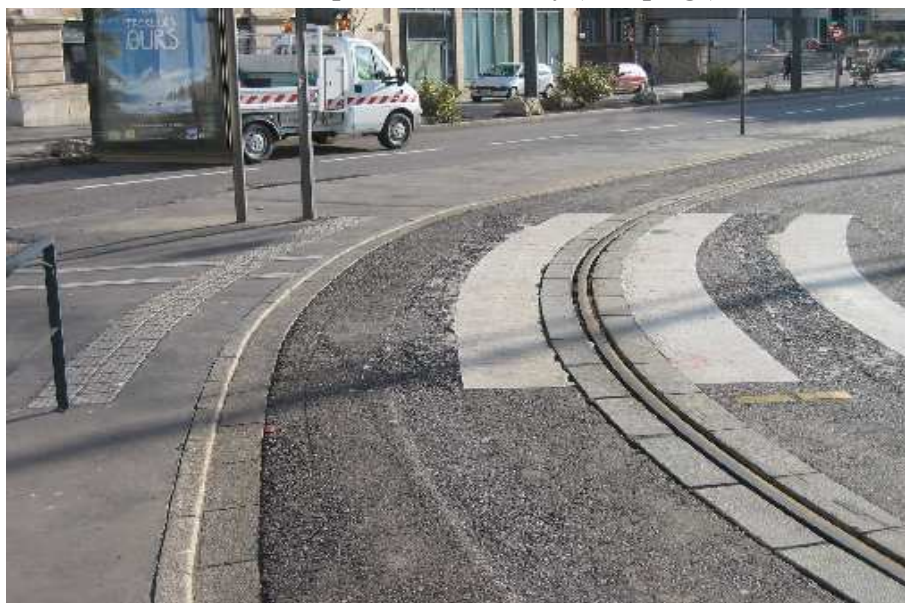
Traversée piétonne à : Nancy (marquage)
