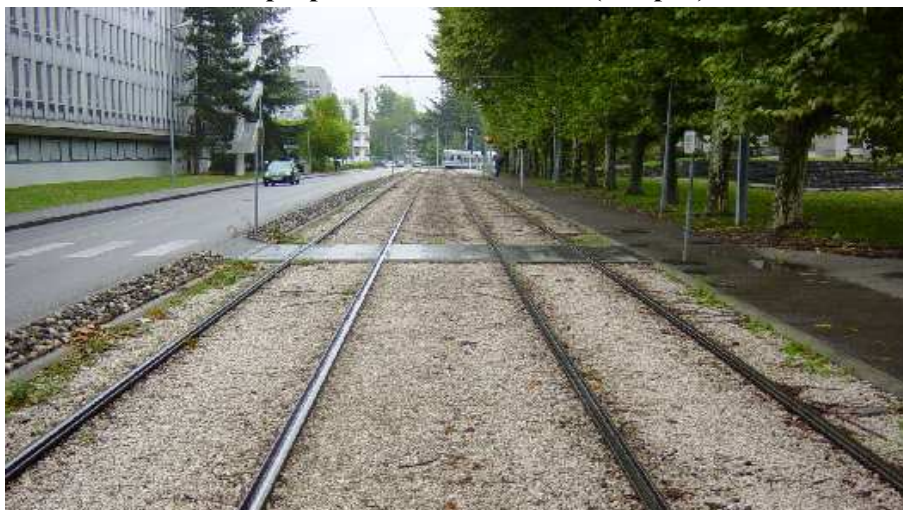
Site propre ballast : Grenoble (campus)
