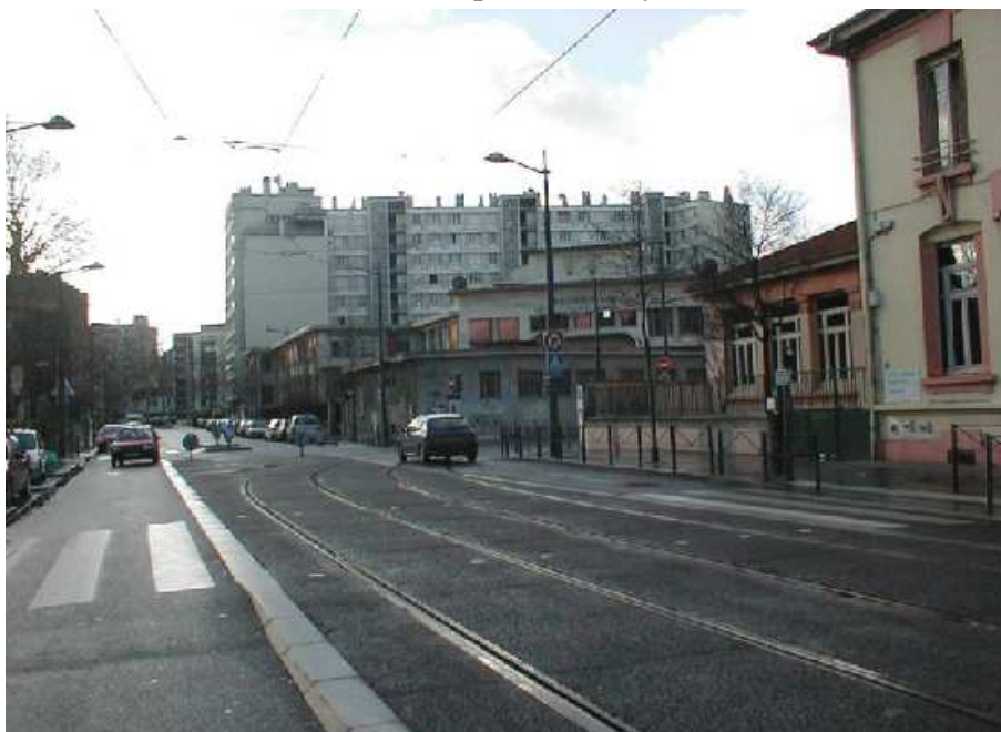
Traversée piétonne : Lyon
