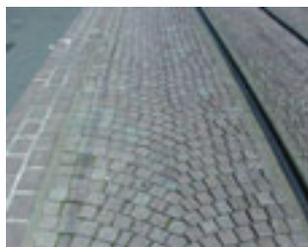
Cinq matériaux de plate-forme ont été utilisés sur les voies du tramway. Il s'agit d'herbe, de sable calcaire (composé d'un liant permettant théoriquement de résister à la pluie et au vent), de dalles, de granit (résistant aux aléas du climat), et de béton.
