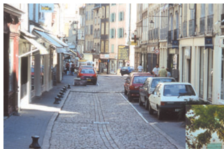
Chicane simplement réalisée par un stationnement alterné
