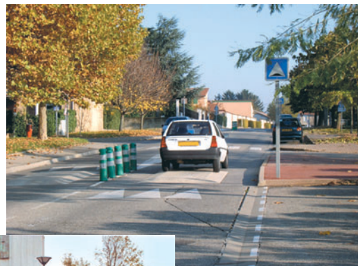
Ralentissement sélectif des voitures grâce aux coussins. Les bus dont l'espacement entre les roues est plus large peuvent les franchir aisément et les vélos peuvent passer sur le côté
