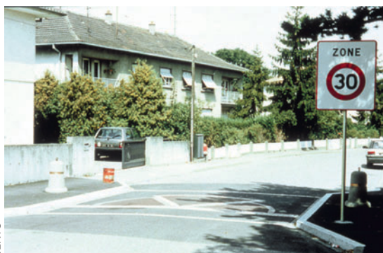
Le traitement d'une entrée de zone 30 peut être simple et efficace
