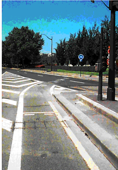
Figure 15 : Piste cyclable sur le quai Branly et boucle de détection de vélo.
