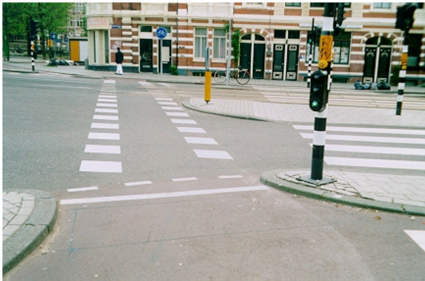
Figure 18 : Feu modal vélo avec boucle magnétique au débouché d'une piste cyclable en Hollande.
