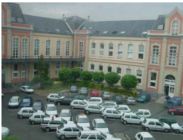
Illustration 11 - La cour intérieure occupée principalement par le stationnement des voitures de service
