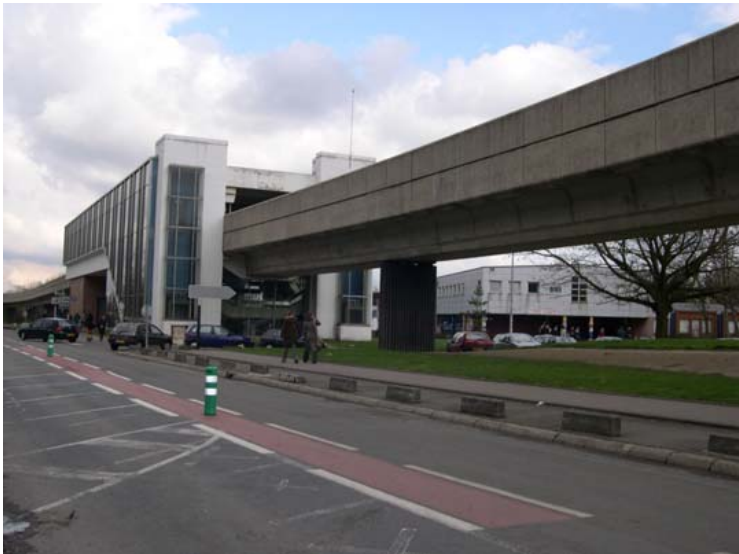
Illustration 8: Cité Scientifique Lille I, de vastes parkings autour de la station de métro (source : Cete Nord-Picardie)
