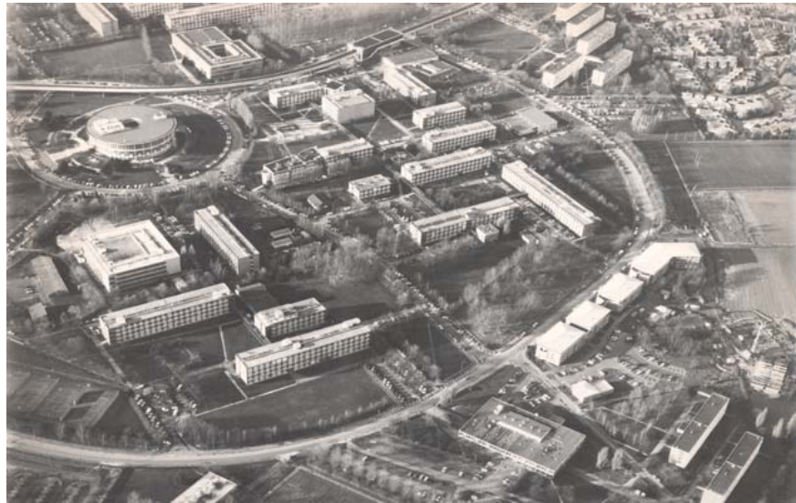
Illustration 4: Parti d'aménagement de la Cité Scientifique (Lille I), une organisation circulaire autour de la bibliothèque centrale et de vastes espaces (source : communauté urbaine de Lille - années soixante-dix)
