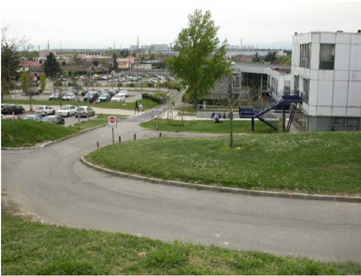
Illustration 3: Université de Lyon II « Porte des Alpes » à Bron, une conception typique des années 60 (source : Cete de Lyon)
