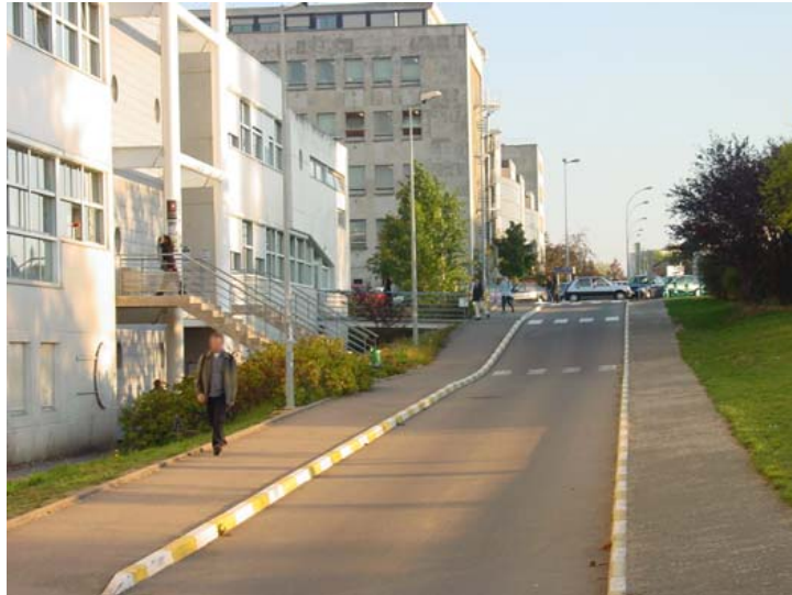
Illustration 31: Université de Bourgogne (Dijon) : des chemins piétonniers lisibles à partir des parkings vers les bâtiments (Source : Cete de Lyon)
