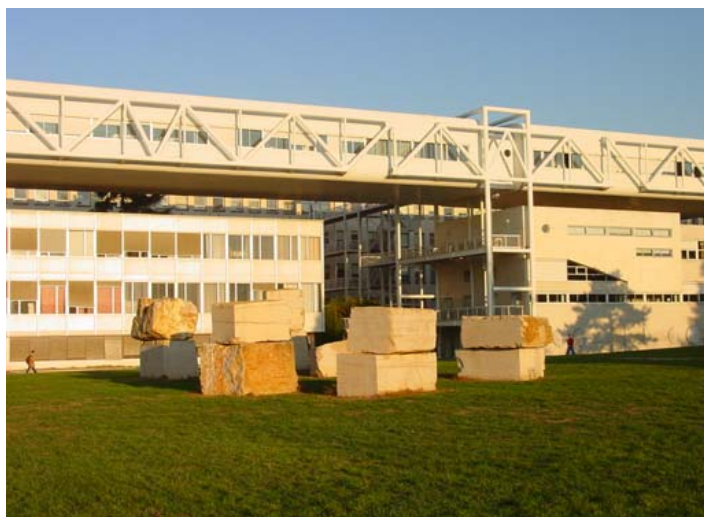
Illustration 23: Des aménagements à usage architectural et défensif - université de Bourgogne (source : Cete de Lyon)
