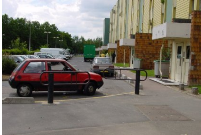
Photo 9 : le stationnement au plus proche des accès d'immeuble...au détriment des accès pompiers (Aulnay, Quartiers Nord)
