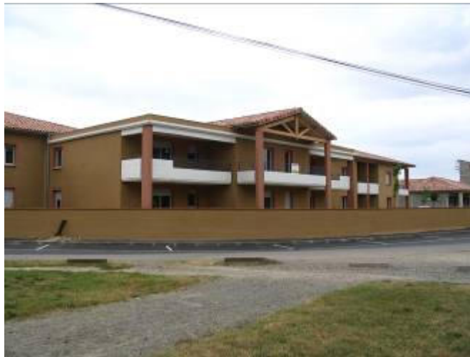
L'un des trois petits collectifs récents construits sur la commune de Lavernose Lacasse
