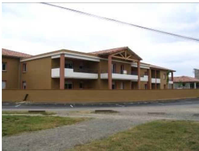
L'un des trois petits collectifs récents construits sur la commune de Lavernose Lacasse
