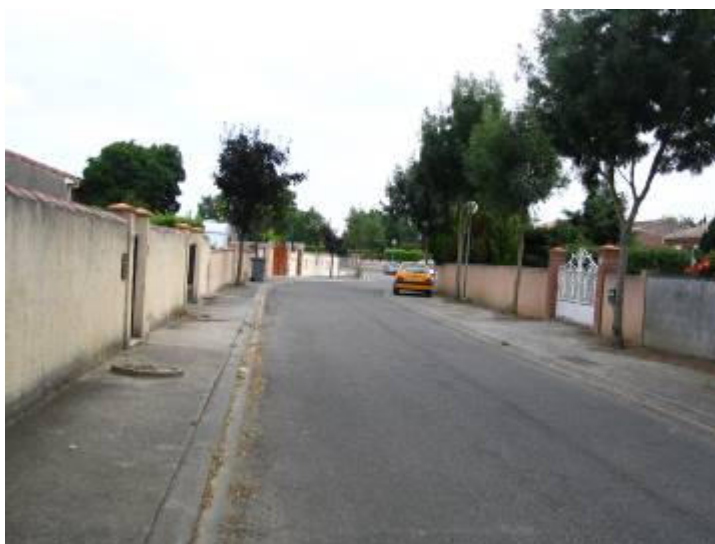
La rue principale du lotissement
