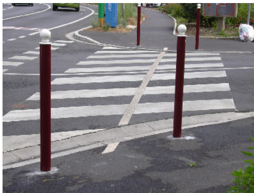
Pas de BEV ; le fil d'Ariane est légèrement prolongé au-delà de fil d'eau dans un matériau identique (Photo : Certu)
