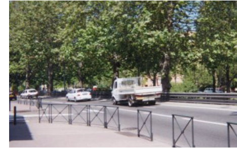
Glissières de sécurité le long du canal
