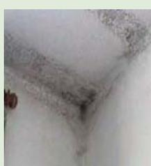
Des moisissures se développent sur les zones froides et notamment le long des poutres qui constituent des ponts thermiques. La totalité du plafond n'est pas encore couverte de moisissures mais l'humidité va imprégner les murs si aucun traitement n'est apporté.
