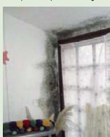
Les moisissures proviennent de l'utilisation de matériaux de construction d'une mauvaise qualité et de l'absence de certains d'entre eux. La menuiserie n'assure pas l'isolation thermique de la pièce.
