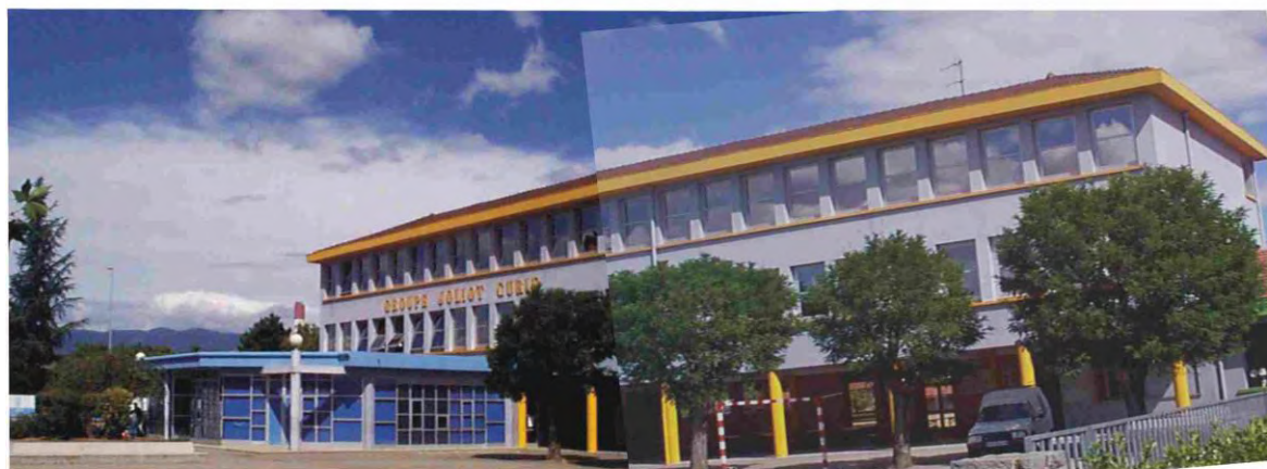
Figure 33 : Vue générale bâtiment principal
