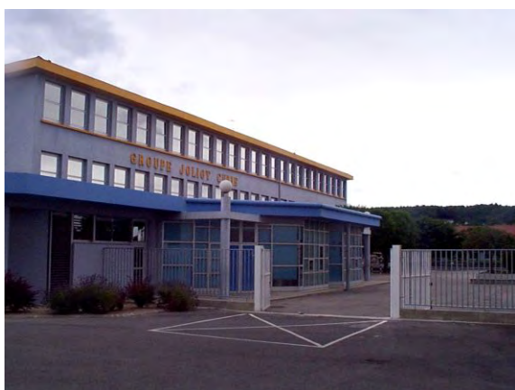
Figure 34 : Bâtiment principal et restaurant scolaire
