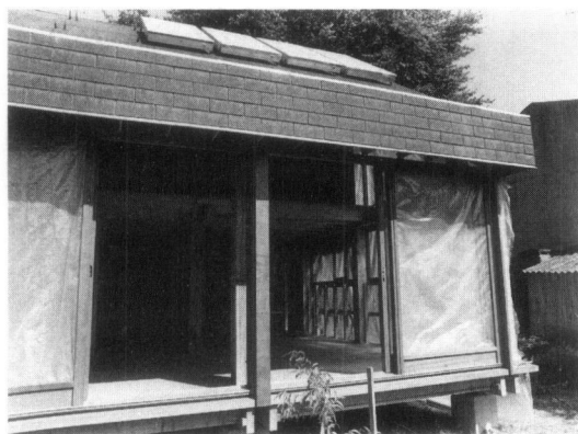
Maison solaire à ossature bois en cours de construction. En raison de ses qualités thermiques, le bois présente un intérêt tout particulier pour la conception des maisons susceptibles d'avoir recours au chauffage solaire.
