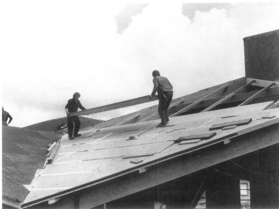
Mise en œuvre de panneaux de particules CTB-H en sa toiture
