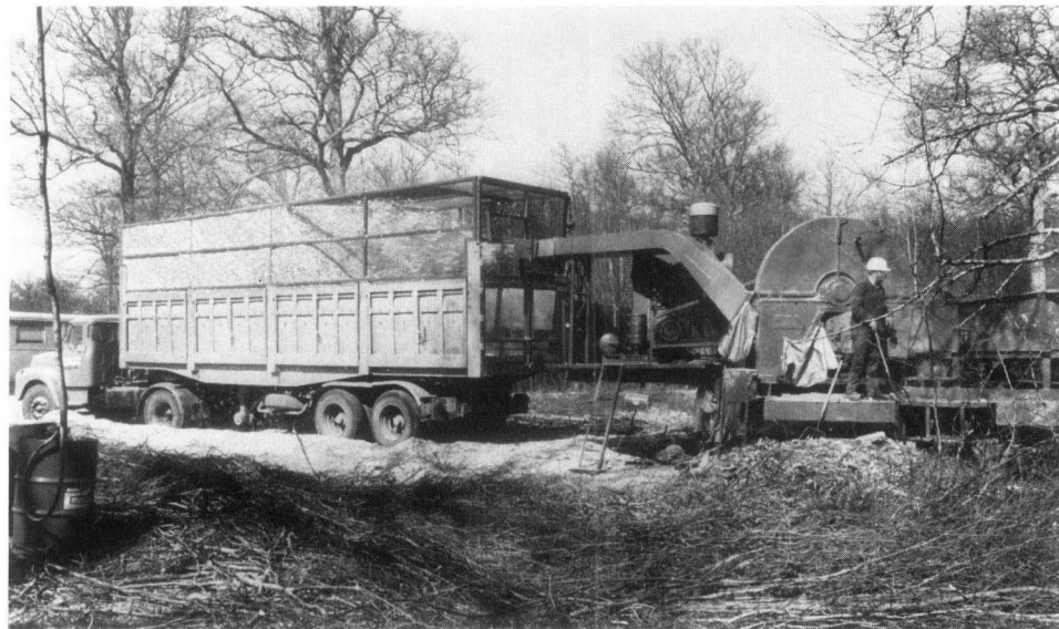
Unité mobile de découpage pour la production de plaquettes papières en forêt.
