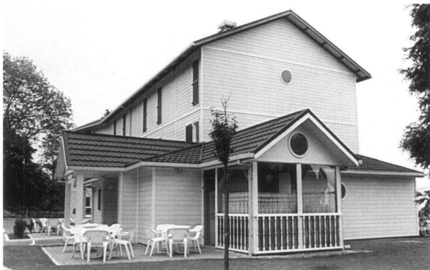
● Ossature bois pour un hôtel (Confortel. La Queue-en-Brie 94)
