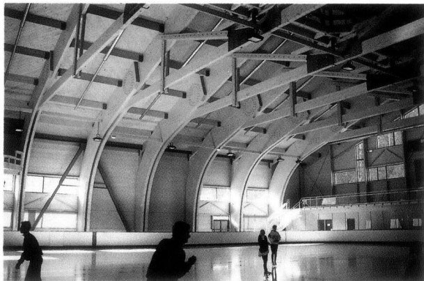
Le CTBA est de plus en plus souvent sollicité pour des interventions bâtiment : expertise, dimensionnement, suivi de chantier...
