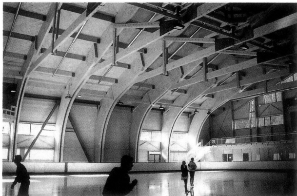
Le CTBA est de plus en plus souvent sollicité pour des interventions bâtiment : expertise, dimensionnement, suivi de chantier...
