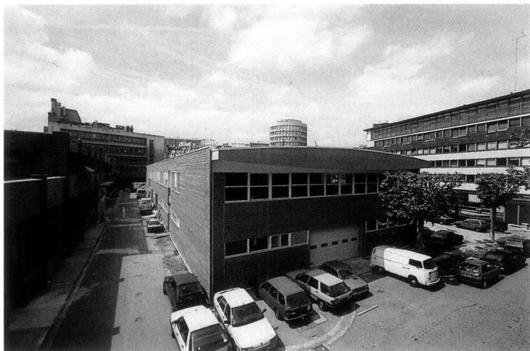
Le nouveau bâtiment de 2500 m 2 de surface
