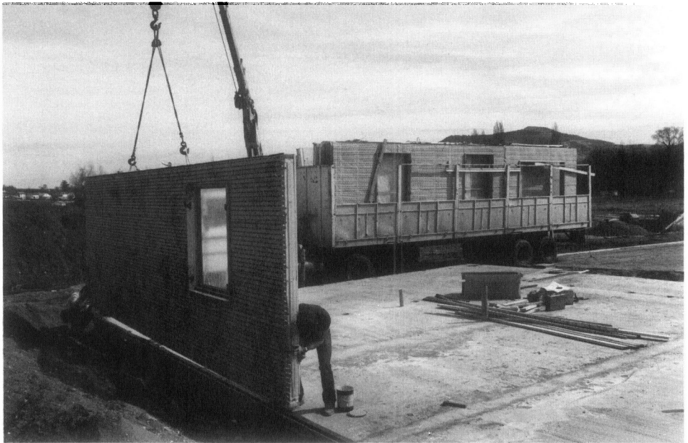
La maison à colombage connaît dans notre pays un grand regain d'intérêt depuis quelques années. C'est pourquoi le C.T.B. a édité en 1981 un ouvrage intitulé «Les maisons à ossature bois ou à colombage» qui est une synthèse technique des connaissances acquises dans ce domaine.
