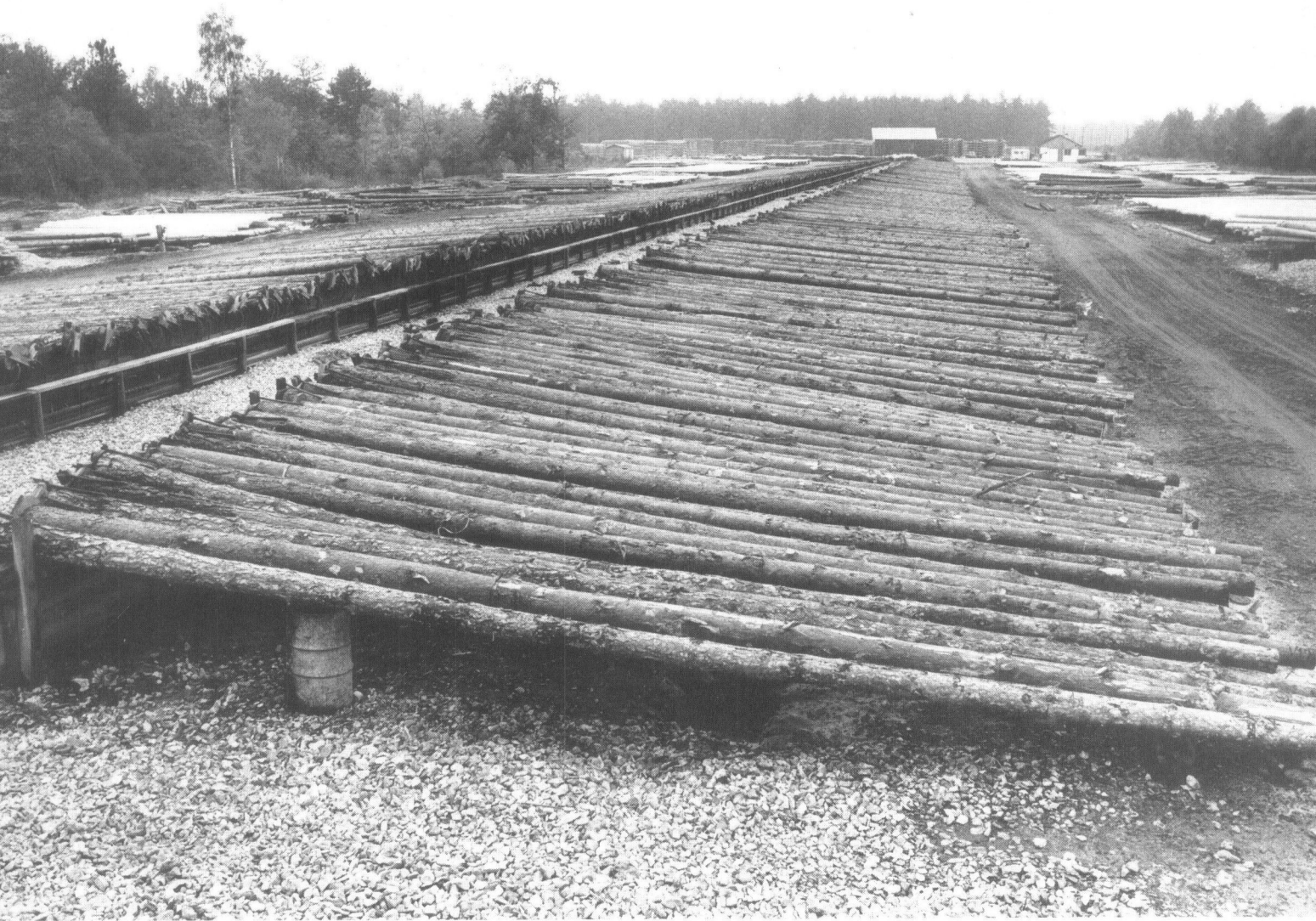
Chantier d'injection de poteaux de ligne.
