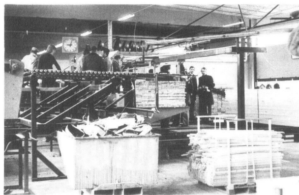
2 Sur cette photo, on distingue à gauche, la cabine acoustique enveloppant les moulurières et, à droite, un ouvrier muni de protecteurs individuels. 3 Délignage et rabotage dans une usine en Suède.
