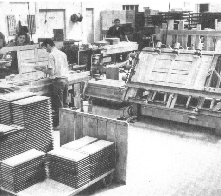
1 Exemple d'étude en cours au C.T.B. : l'amélioration de la fabrication industrielle des meubles massifs : ici, conception du meuble massif par assemblage de sous-ensembles. Poste de démontage de sous-ensembles sur cadreuse pneumatique.
