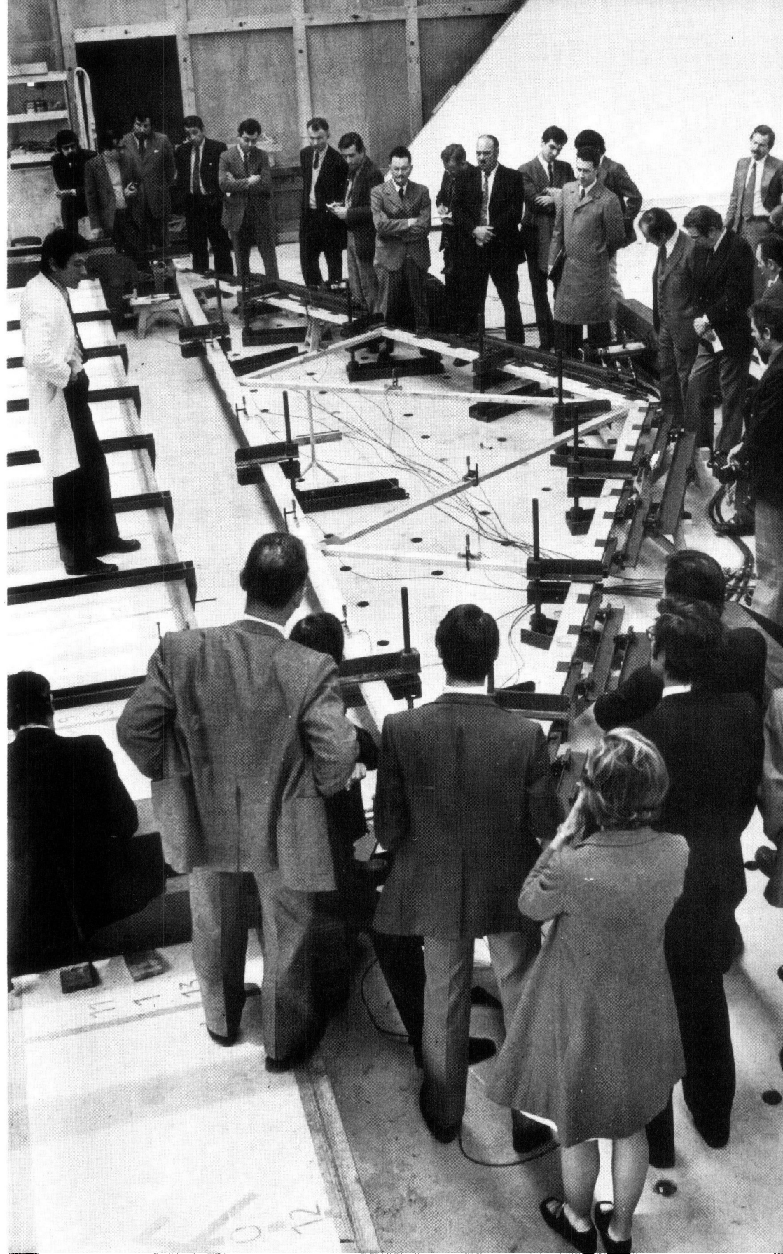
Ci-contre : présentation du banc d'essais, en grandeur réelle, des structures planes, à des industriels français, le 2 avril 1974, par le Centre Technique du Bois dans sa station d'essais de Champs-sur-Marne.
