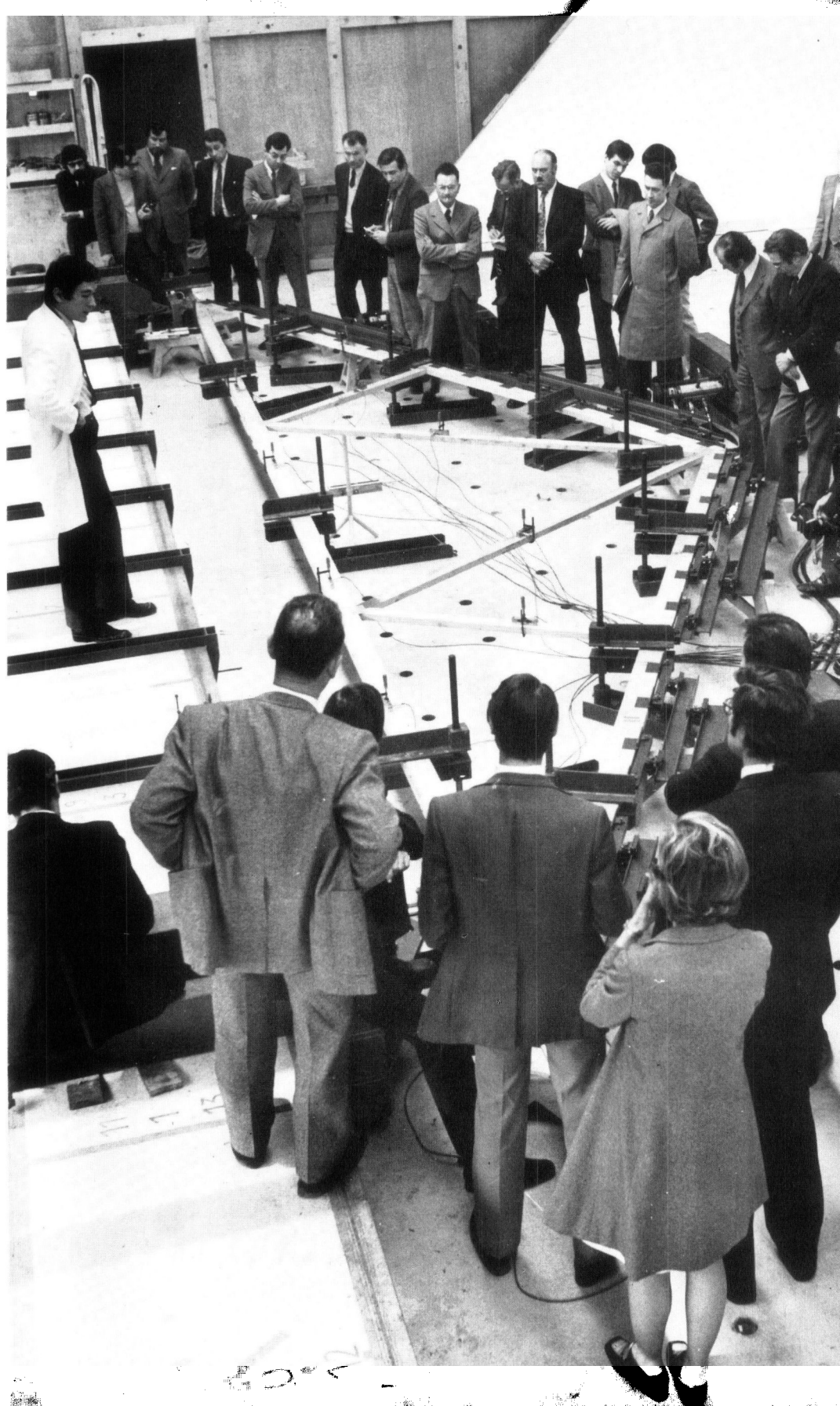
Centre : présentation du banc d'essais, en grandeur réelle, des structures planes, à des industriels français, le 2 avril 1974, par le Centre Technique du Bois dans sa station d'essais de Champs-sur-Marne.
