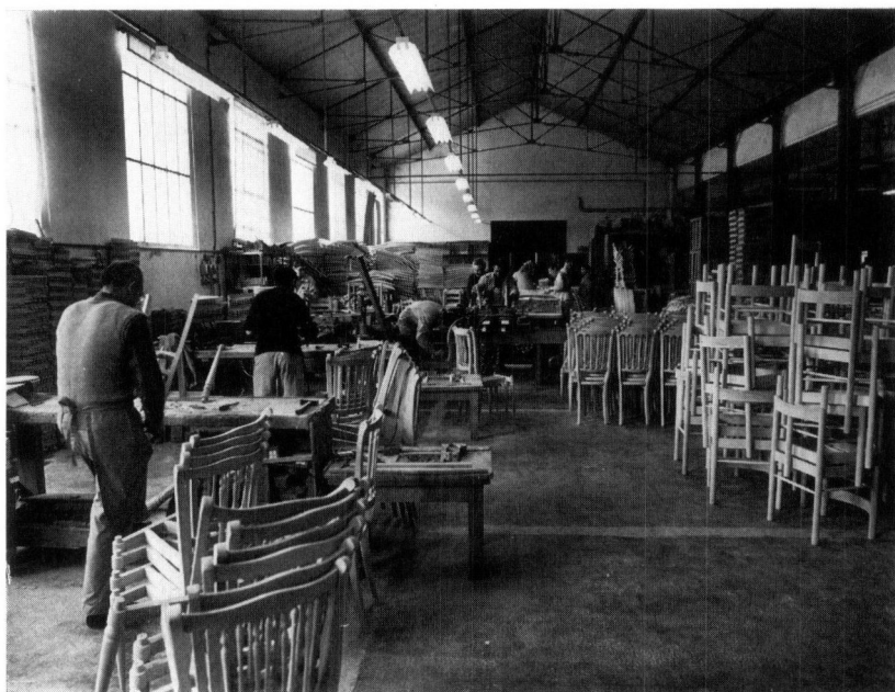
Atelier de fabrication industrielle de chaises.
