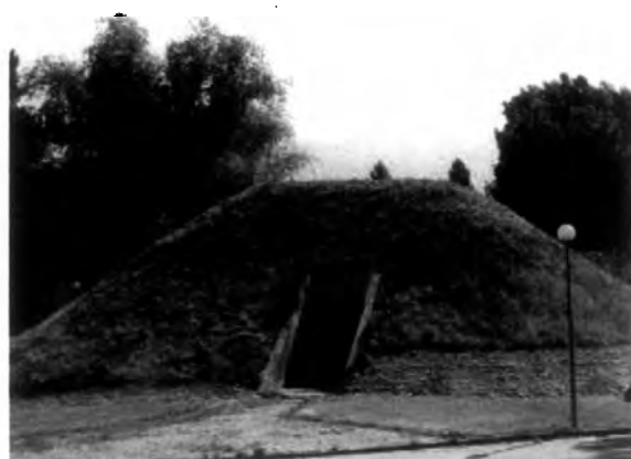
(Photo 2003, Laboratoire semi-enterré de mesures de radioactivité)
