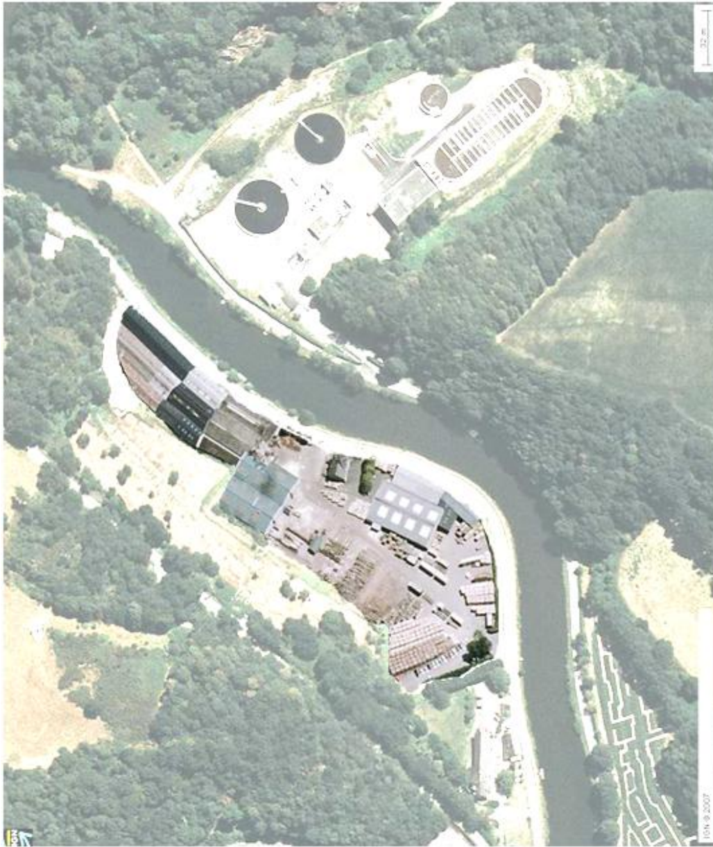
Figure 19 : Vue aérienne de l'entreprise Norman (IGN, 2007)
