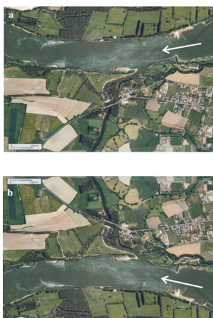
Figure 5 - Exemple de cône alluvial actuel, Notre-Dame-du-Marillais (49) à la confluence entre l'Èvre et la Loire (a). En (b), l'image a été inversée pour retrouver une orientation similaire à celle de la séquence d'Étiolles.
